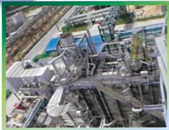
HRSG : Steam. 68 t/h, Pressure 55.9 kg/cm 2 , Temp 422 °C X 6 Unit
